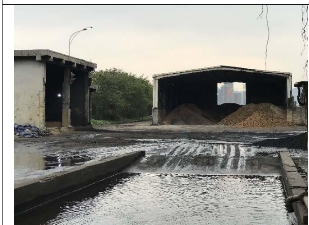
卸煤坑和干污泥储棚
