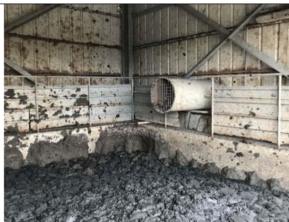
湿污泥恶臭集气系统
