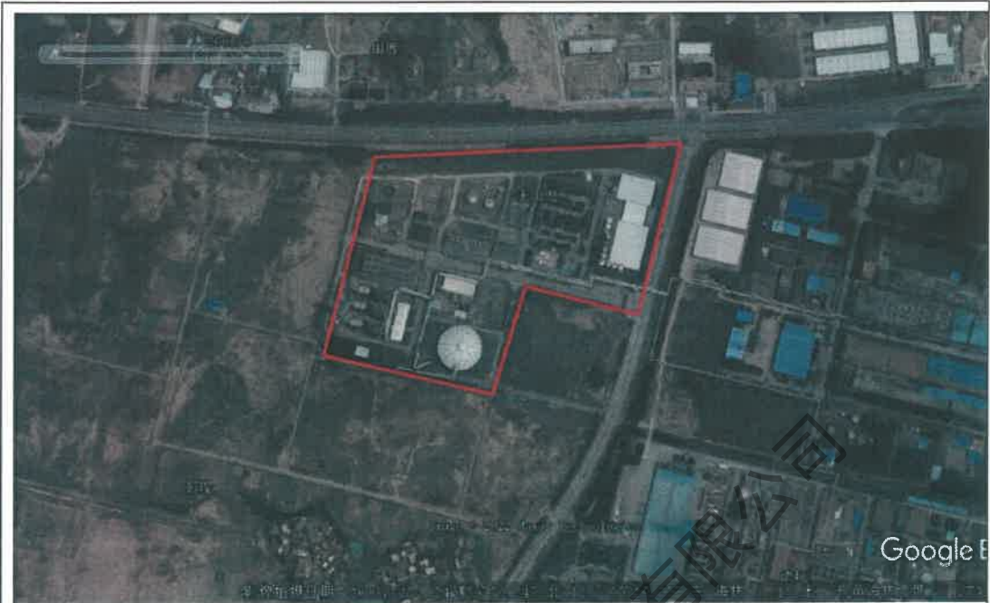
拍摄日期 2008.08（建设基本完成）
