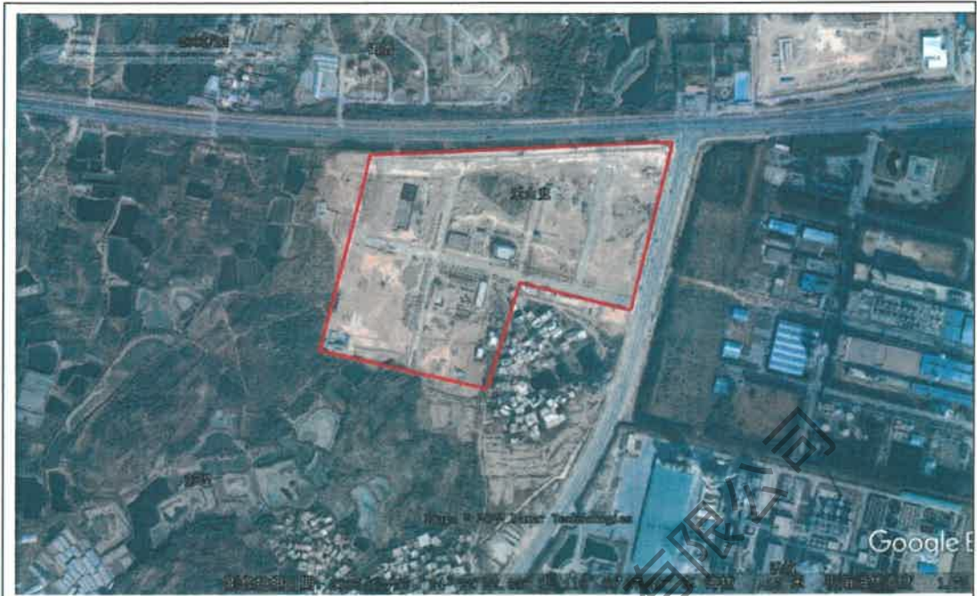
拍摄日期 2003.12（土建阶段，按主体工程（瓶片部、工务部）、公用工程、储运工程分区建设，具体分区与现状基本一致）
